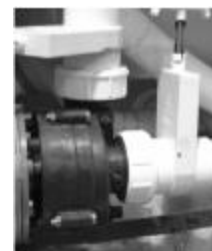
Vanne Guillotine et Raccord de Pompe
