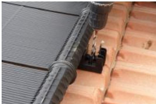
**6** Faites glisser le coussin jusqu'au toit, par le trou inférieur. Pour les toits en tuiles de tonneau, placez un coussin en caoutchouc sous chaque pince.
