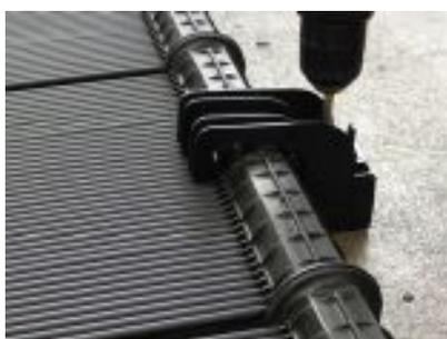
Sur un toit dont la pente est supérieure à 30° ou dans les régions venteuses, il est recommandé de renforcer le pince Crocodile avec deux vis percées à l'arrière et sur le côté (le socle de montage est fabriqué avec deux trous spéciaux exactement à cet effet).
