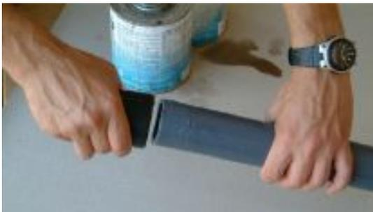
**3** Insérez l'extrémité du tuyau dans le raccord avec un léger mouvement de torsion pour répartir la colle uniformément et sceller le joint.
