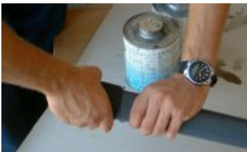
**4** Maintenez-le en position pendant 5 à 10 secondes (plus longtemps lorsque la température ambiante est basse) pour permettre au colle PVC de prendre légèrement. Essuyez l'excédent de colle PVC.
