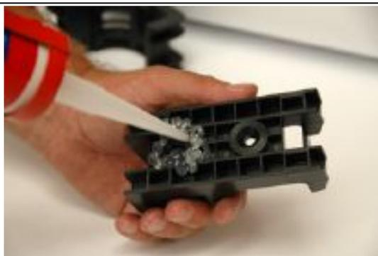
**4** Appliquez généreusement du mastic d'étanchéité sur la partie inférieure des pinces Crocodile où le toit entrera en contact.
