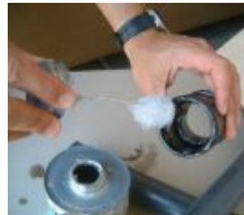
**2** Immédiatement après le nettoyage, appliquez du colle PVC d'abord sur le raccord, puis sur l'extrémité du tuyau.
